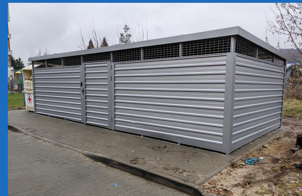
wiata śmietnikowa przy ul. Szkolnej 7, 9
