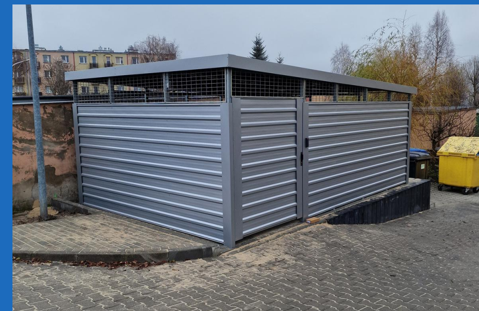
wiata śmietnikowa przy, ul. Białe Zagłębie 5
