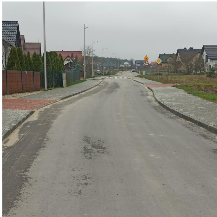
Budowa ul. Diamentowej w Kowali
