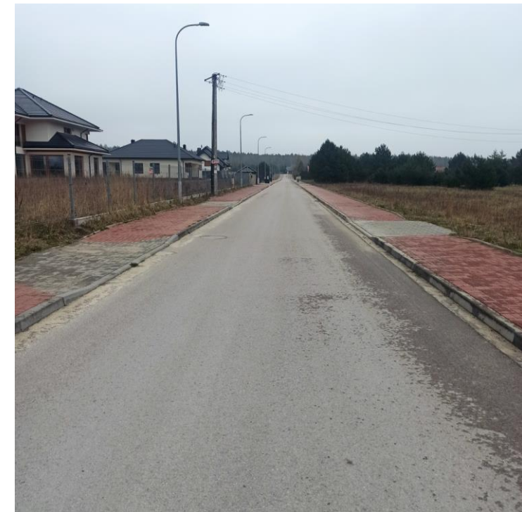
Remont ul. Dolomitowej w Szewcach
